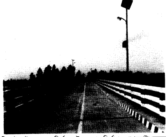
চিত্র: টাঙ্গাইল জেলার মির্জাপুর উপজেলায় মির্জাপুর-পাথরঘাটা সড়কে বংশাই নদীর ওপর নির্মিত ৩০০ মিটার দীর্ঘ পিসি গার্ডার ব্রিজ
